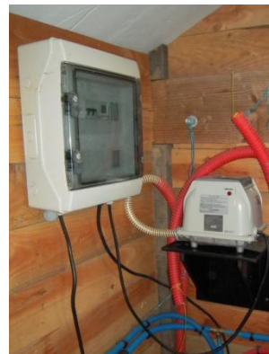
EL-S-60 monté dans un coffre insonorisé et coffret de commande
