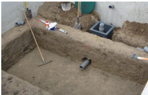
Terrassement du filtre
