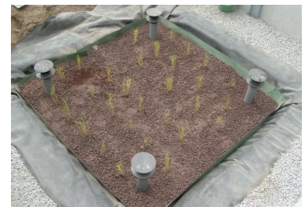
Vue du filtre lors de la mise en service
