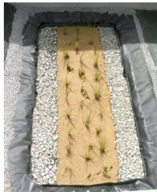
Vue du filtre horizontal lors de la mise en service
