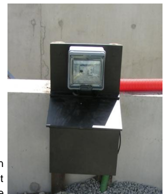
EL-S-60 monté dans un coffre insonorisé et coffret de commande
