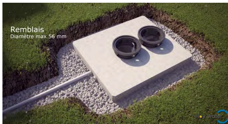
Fig-27 : Remblaiement
