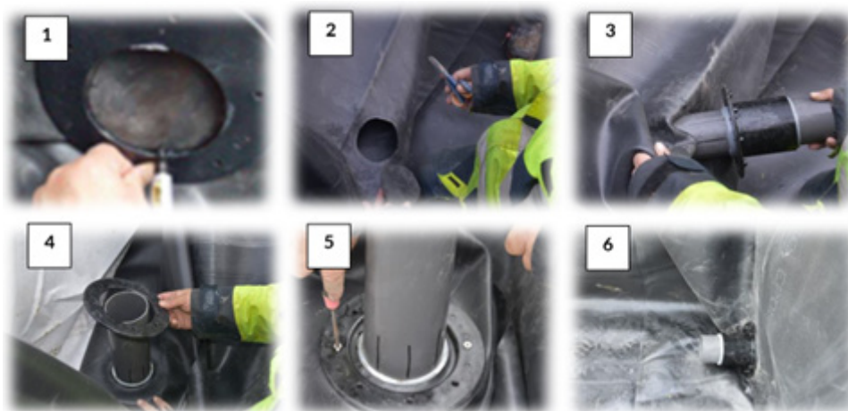
Procédure d'installation de la traversée de paroi
