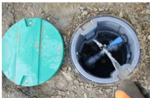
Entretien du poste de relevage
