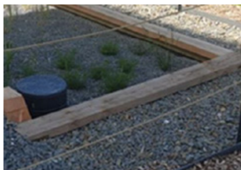
Exemples de protections sanitaires à mettre en place sur le tuyau d'alimentation du filtre à écoulement horizontal
