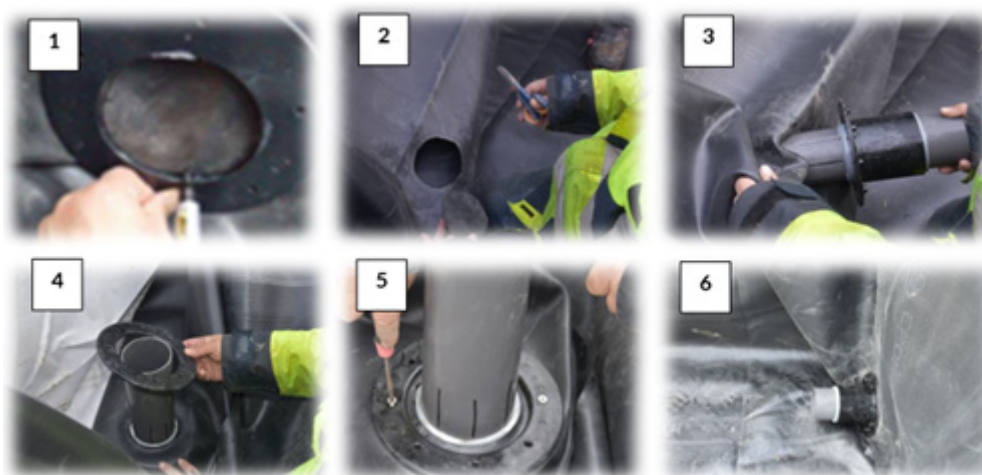
Procédure d'installation de la traversée de paroi
