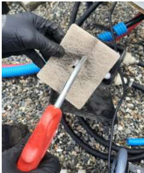
Figure 12: Nettoyage de filtre à air
